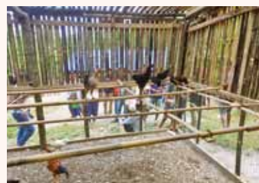
新たに建設された鶏舎。
