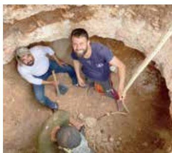
雨水用貯水槽の建設
