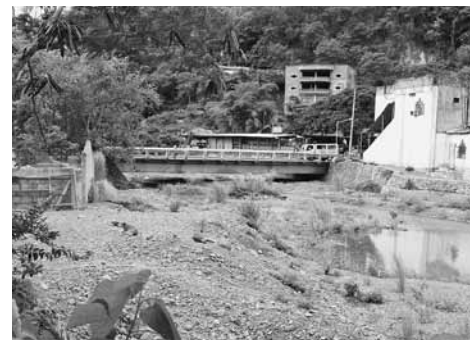
JICAのプロジェクトが守ろうとしているサンタフェ橋。
