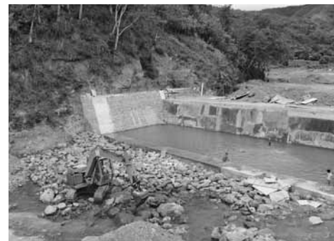
建設が始まったサボダム。
