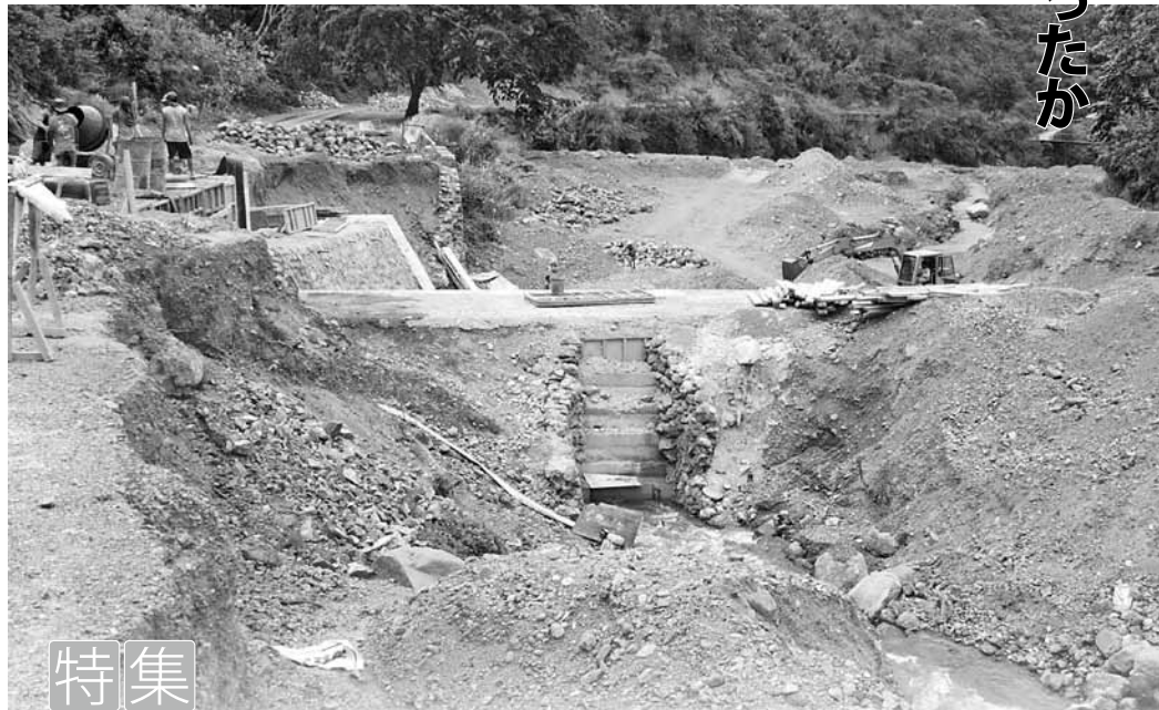
フィリピン・ヌエバビスカヤ州のサボダム建設現場。(P7参照)
