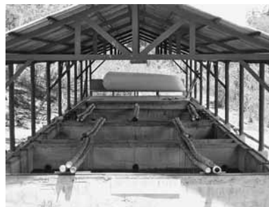
液肥が溜まるタンクとBM活性水を製造するタンク5槽。
