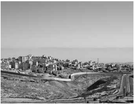
コンクリートの人工物が、意志を持った生き物のように伸びている。
